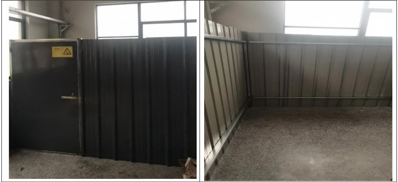
图 4-3 危废间建设情况
