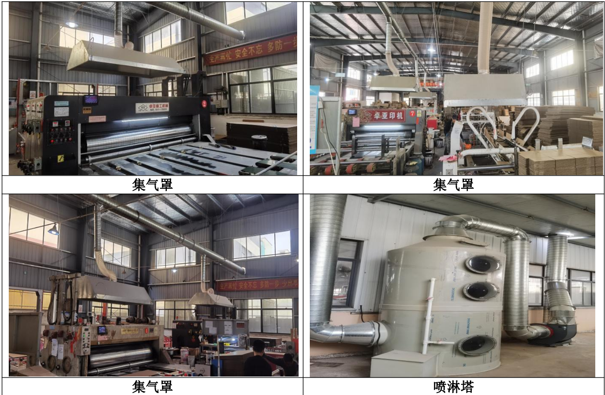
图 3-1 废气产污结点和处理设施现场图
