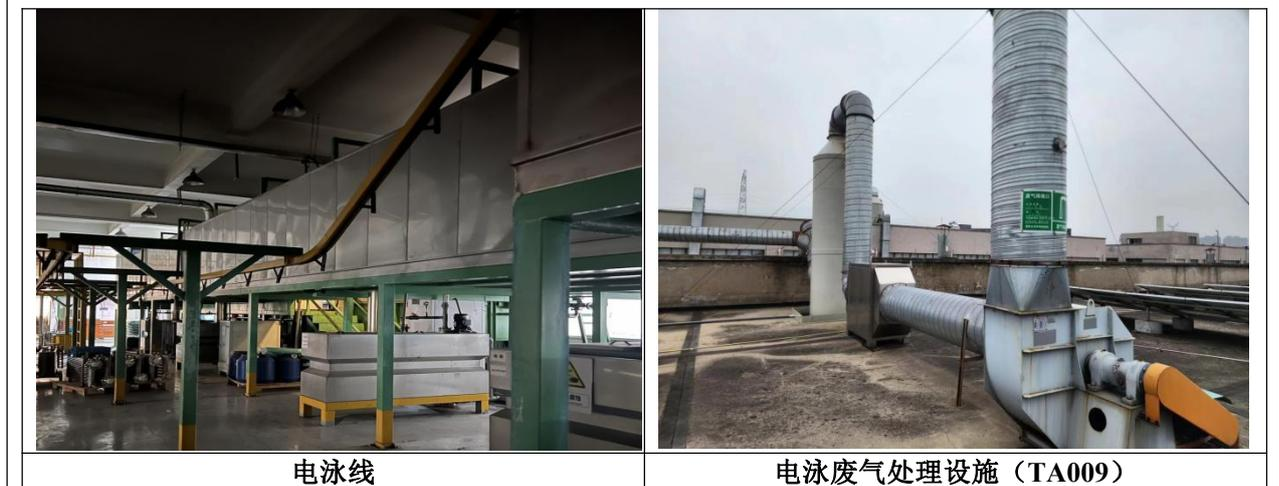
图 3-5 电泳废气产污结点和处理设施现场图
