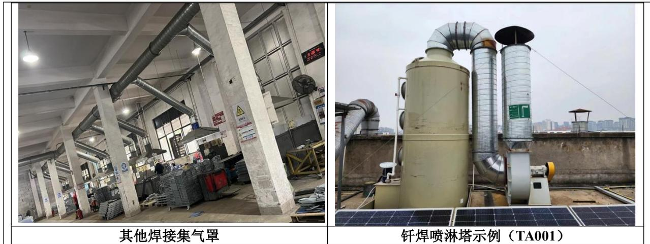
图 3-3 焊接废气产污结点和处理设施
