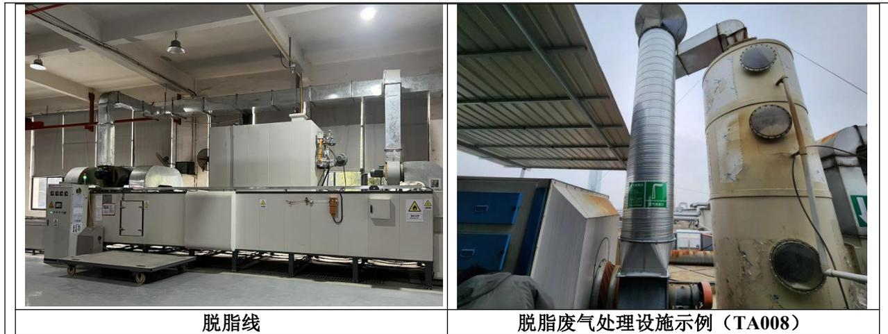
图 3-4 脱脂废气产污结点和处理设施现场图
