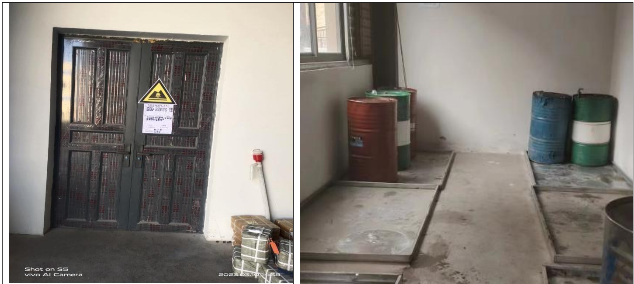
危废间落实情况
