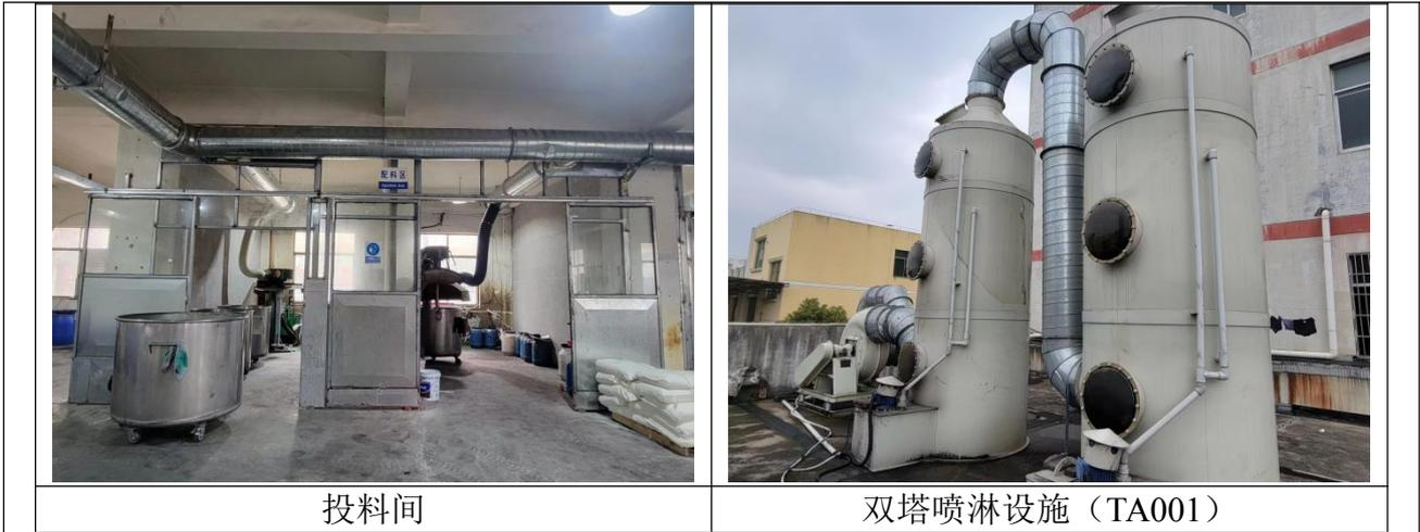
图 3-1 项目车间废气产污点及处理设施现场图
