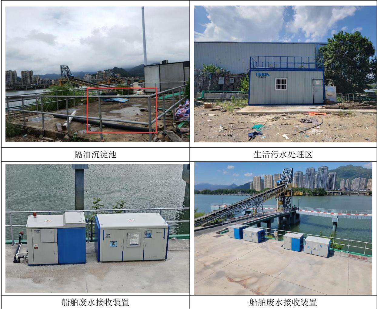
图 5-1 污水处理、收纳装置现场图
