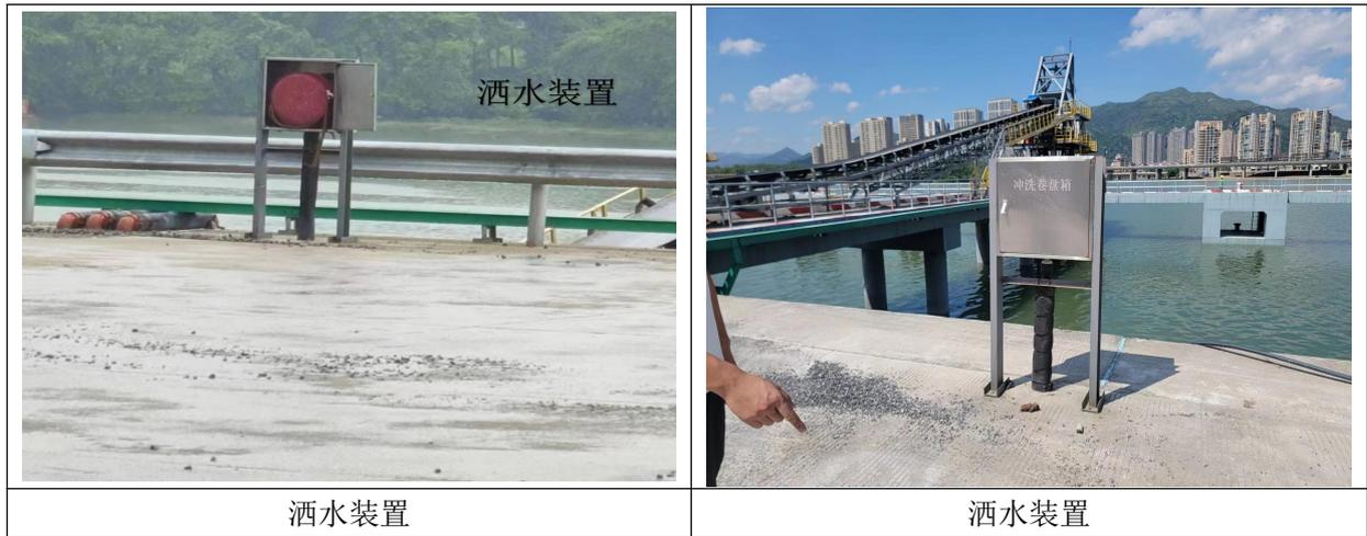
图 6-1 喷淋系统现场图
