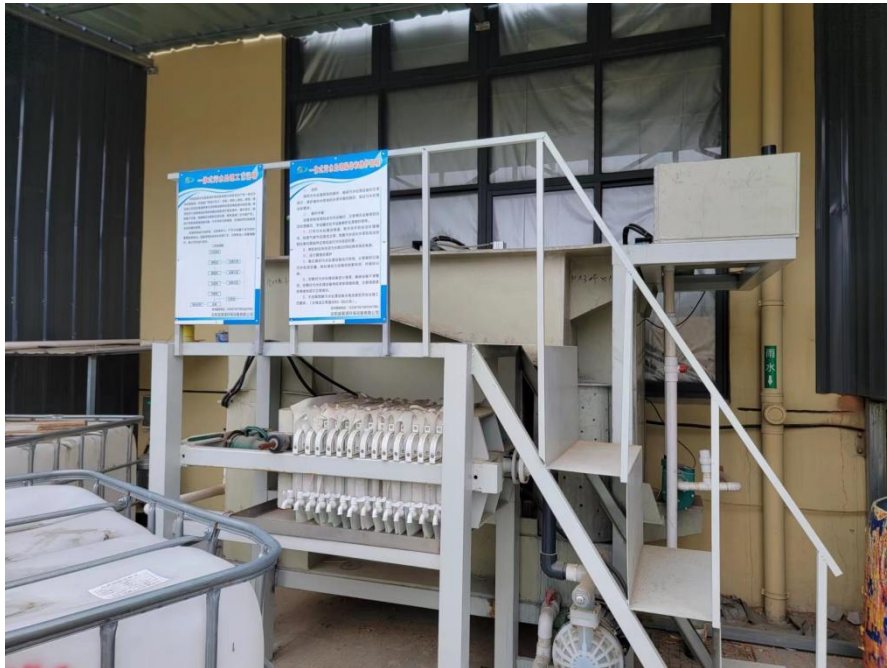
图 3-1 污水处理设施现场图
