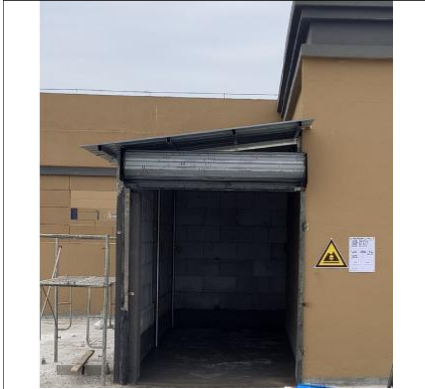
图 4-4 危废储存防治落实情况
