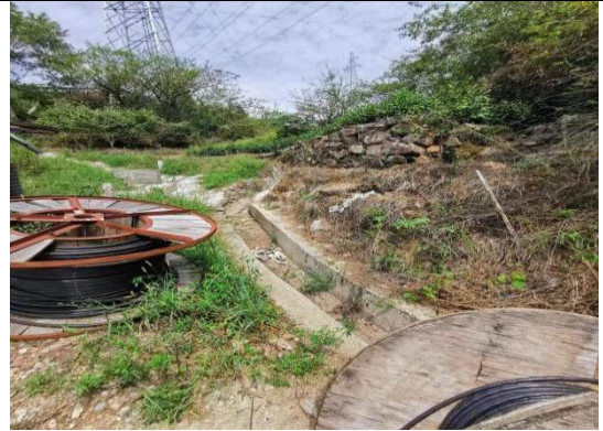
场区周边排水沟
