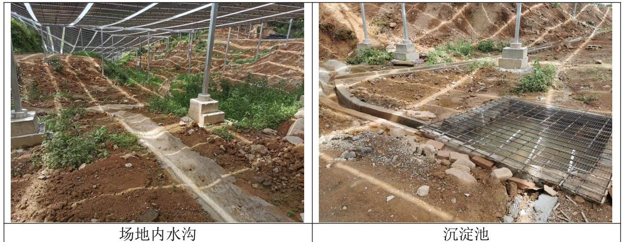
图 2-8 冲洗水收集处理现场图
