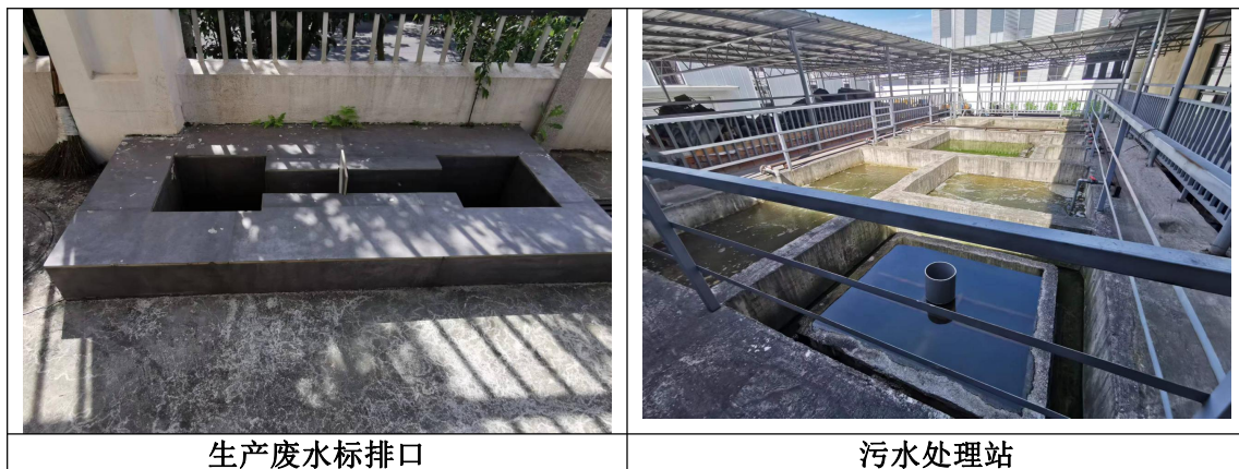
图 5-2 部分废水产污结点现场图
