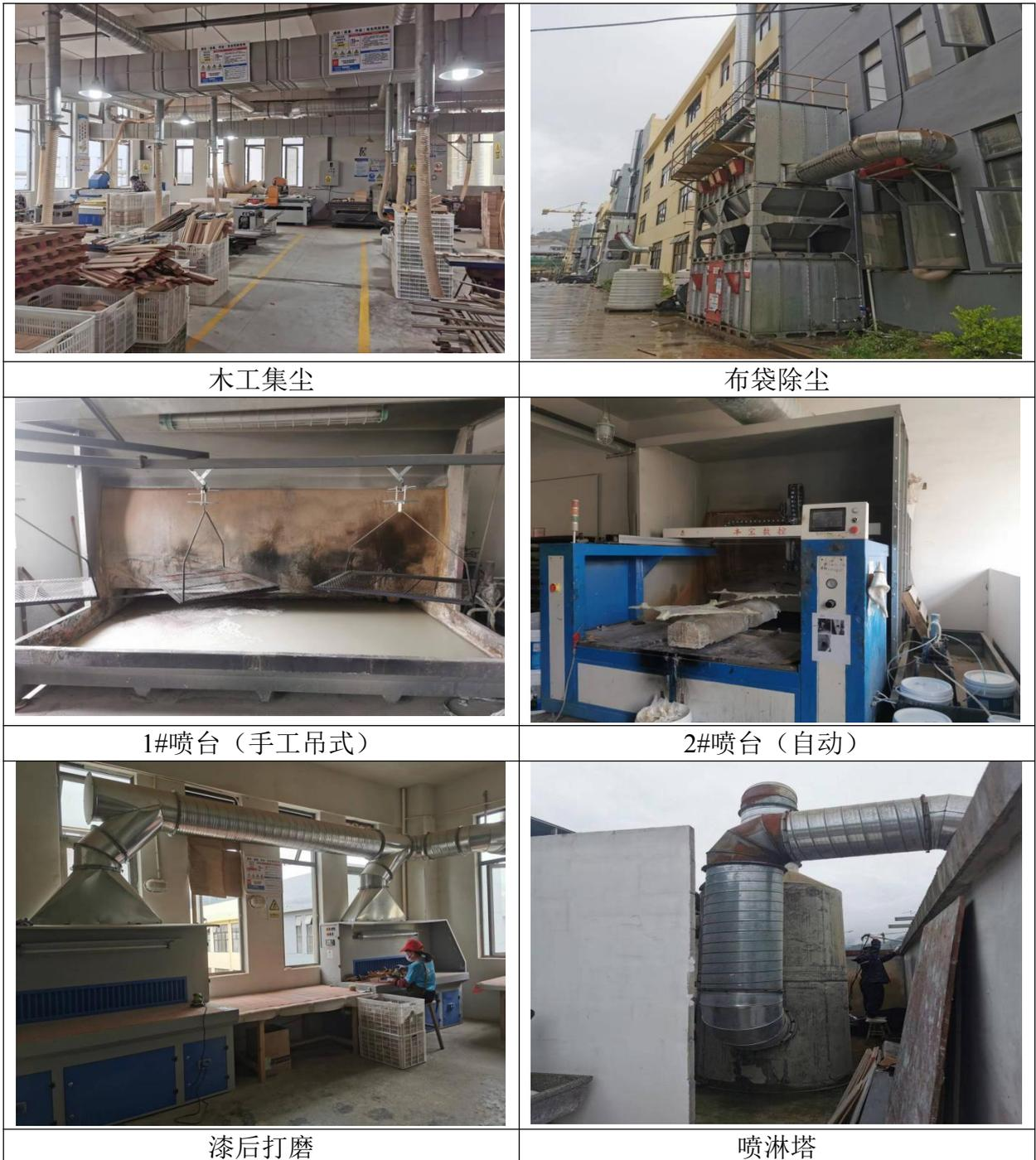
图 3-2 废气产污点及处理设施现场图
