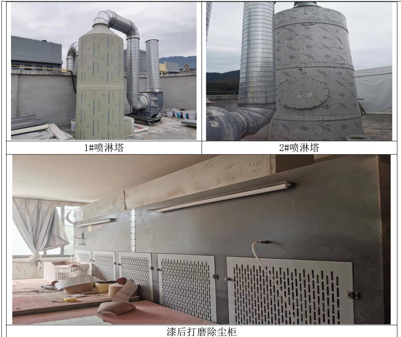
图 3-2 废气产污点及处理设施现场图
