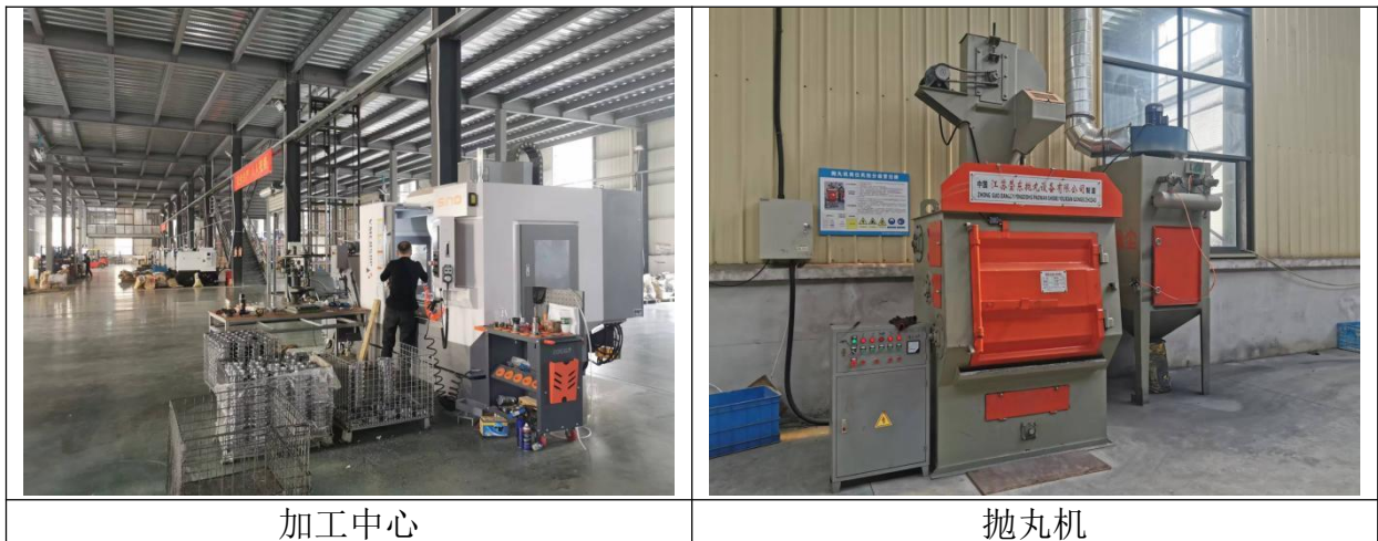
图 3-2 项目废气产污结点和处理设施现场图
