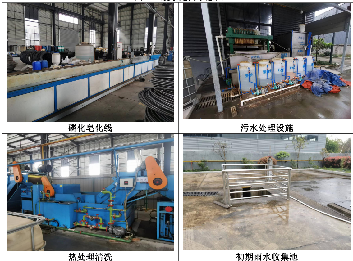
图 5-2 部分废水产污结点现场图
