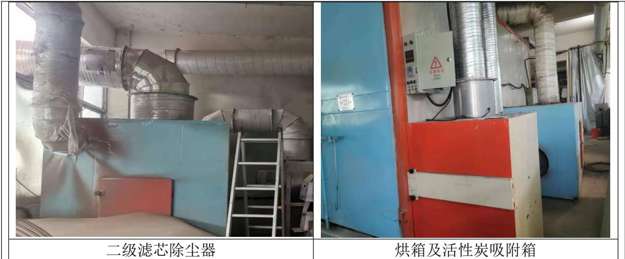
图 3-1 喷塑、固化工序产污节点与处理设施
