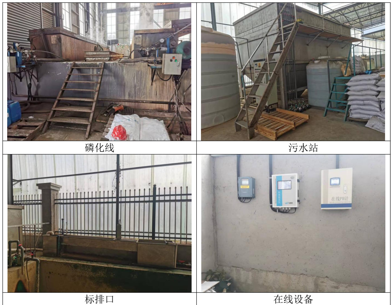
图 3-2 污水处理设施现场图
