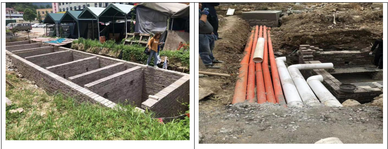
图 3-1 污水收集池和管道铺设图
