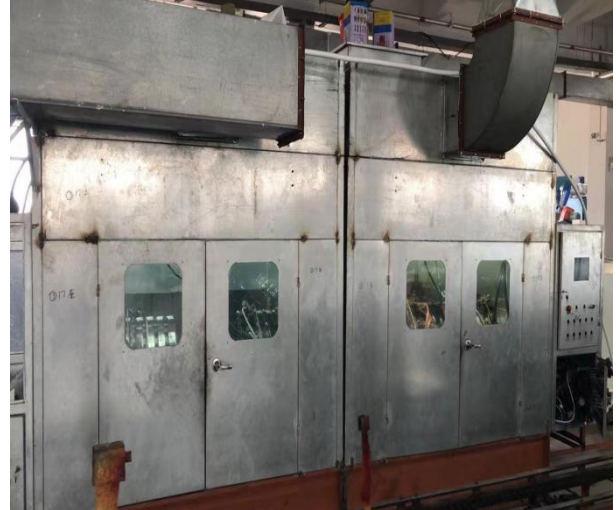
流水线喷漆室
