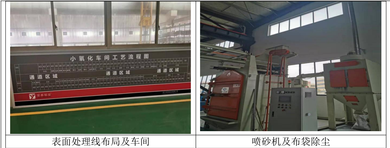
图 3-3 废气产污点及处理设施现场图
