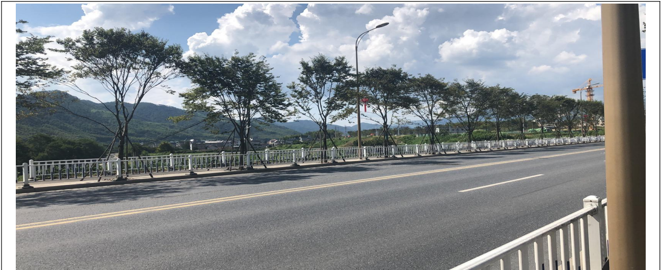
改扩建后公路现状
