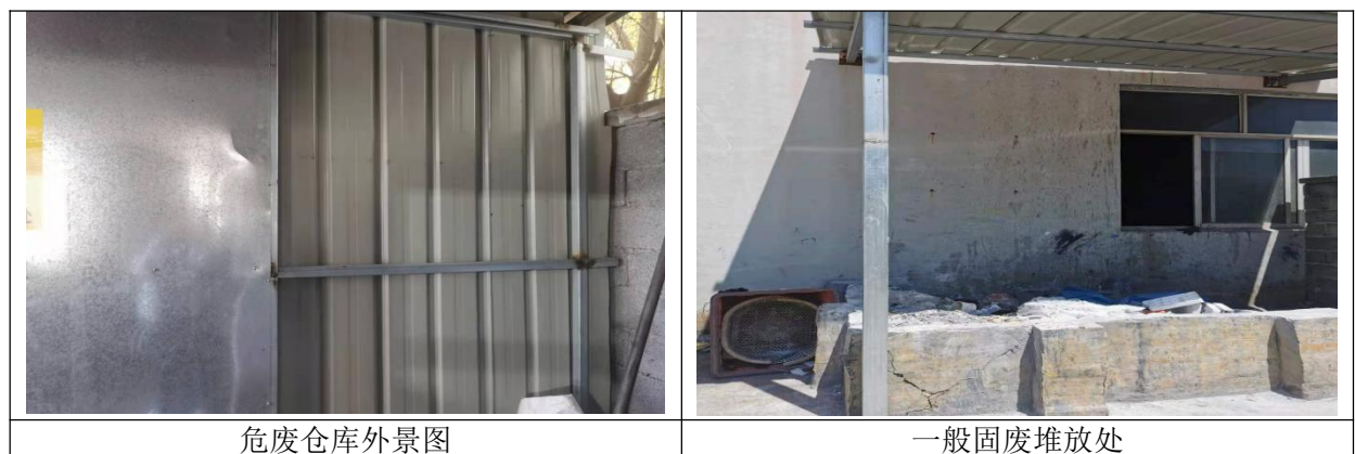
图 3-6 固废堆放区现场图
