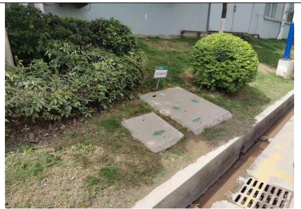
厂区道路水收集池2
