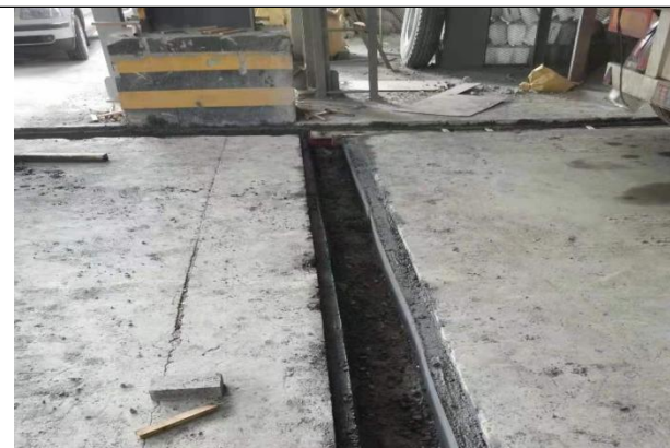
砂浆车间部分收集沟
