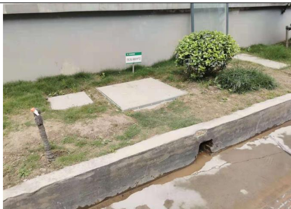
厂区道路水收集池1
