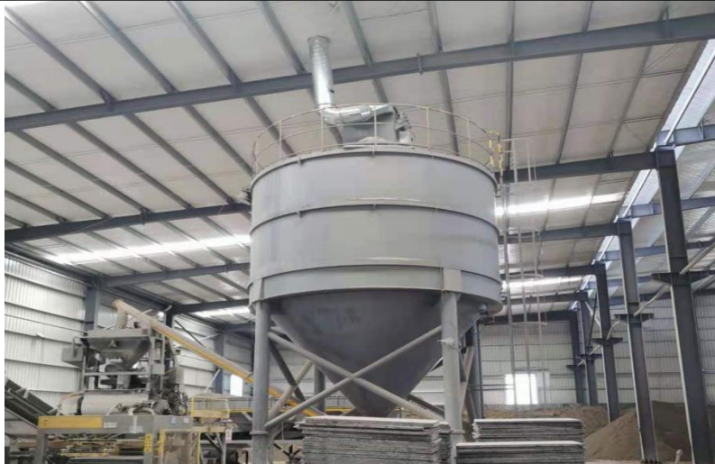
图 3-6 再生砖车间废气产污结点与处理现场图
