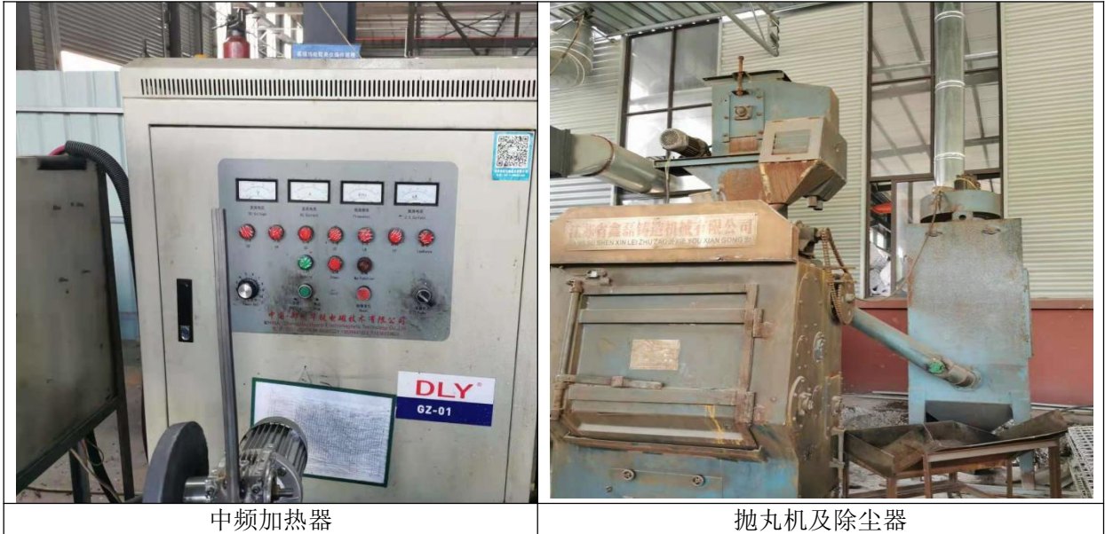
图 3-4 油烟废气和抛丸废气产污现场图
