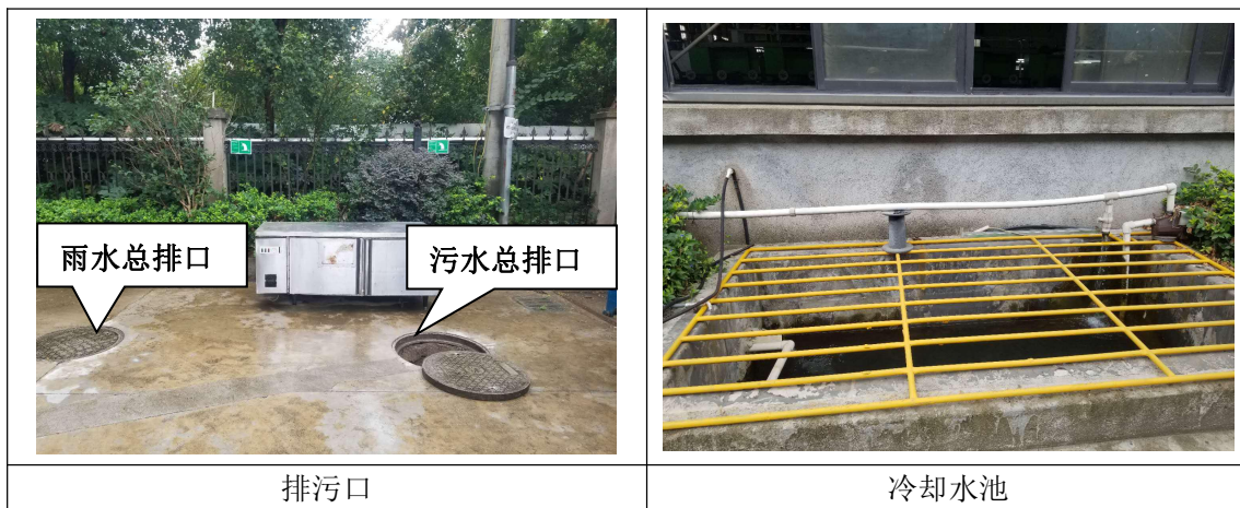
图 5-1 厂区内冷却池和排放口现场图
