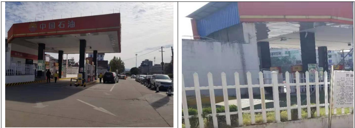
图 4-4 项目加油区、挡墙现场图
