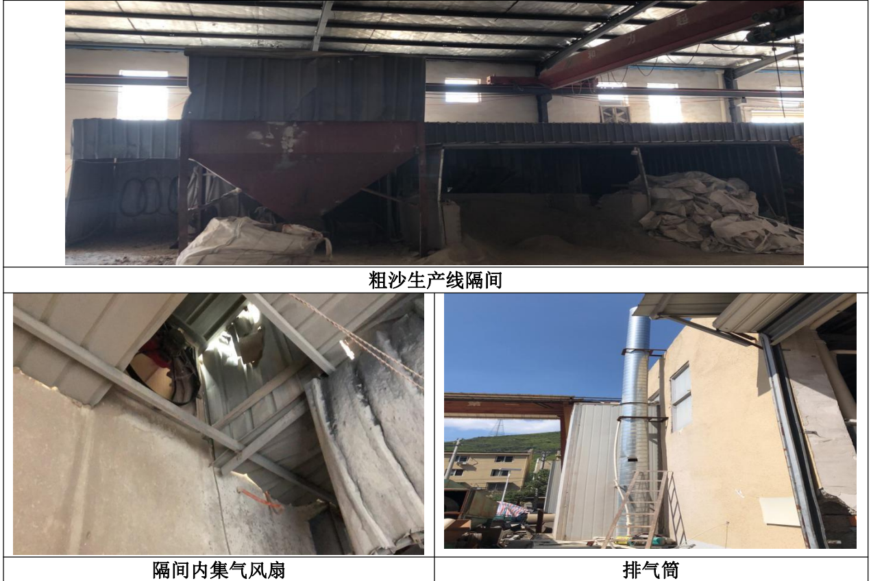
图 4-2 车间内 1#生产线粉尘防治情况
