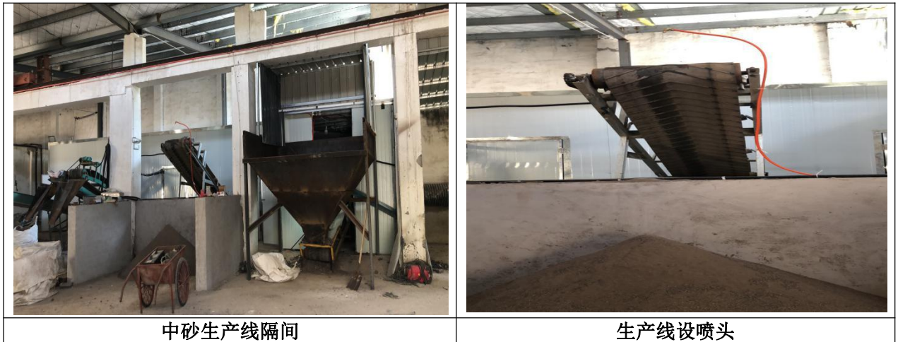
图 4-4 车间内 3#生产线粉尘防治情况
