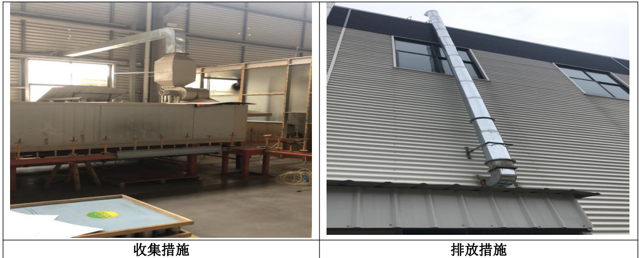
图 4-3 烘干固化废气防治现场情况
