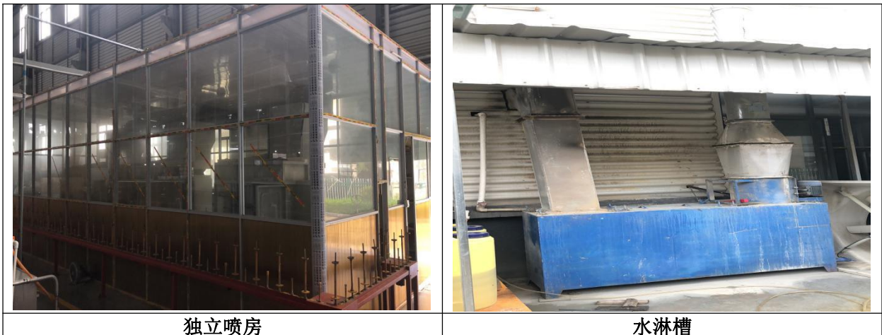
图 4-2 喷塑粉尘防治现场情况
