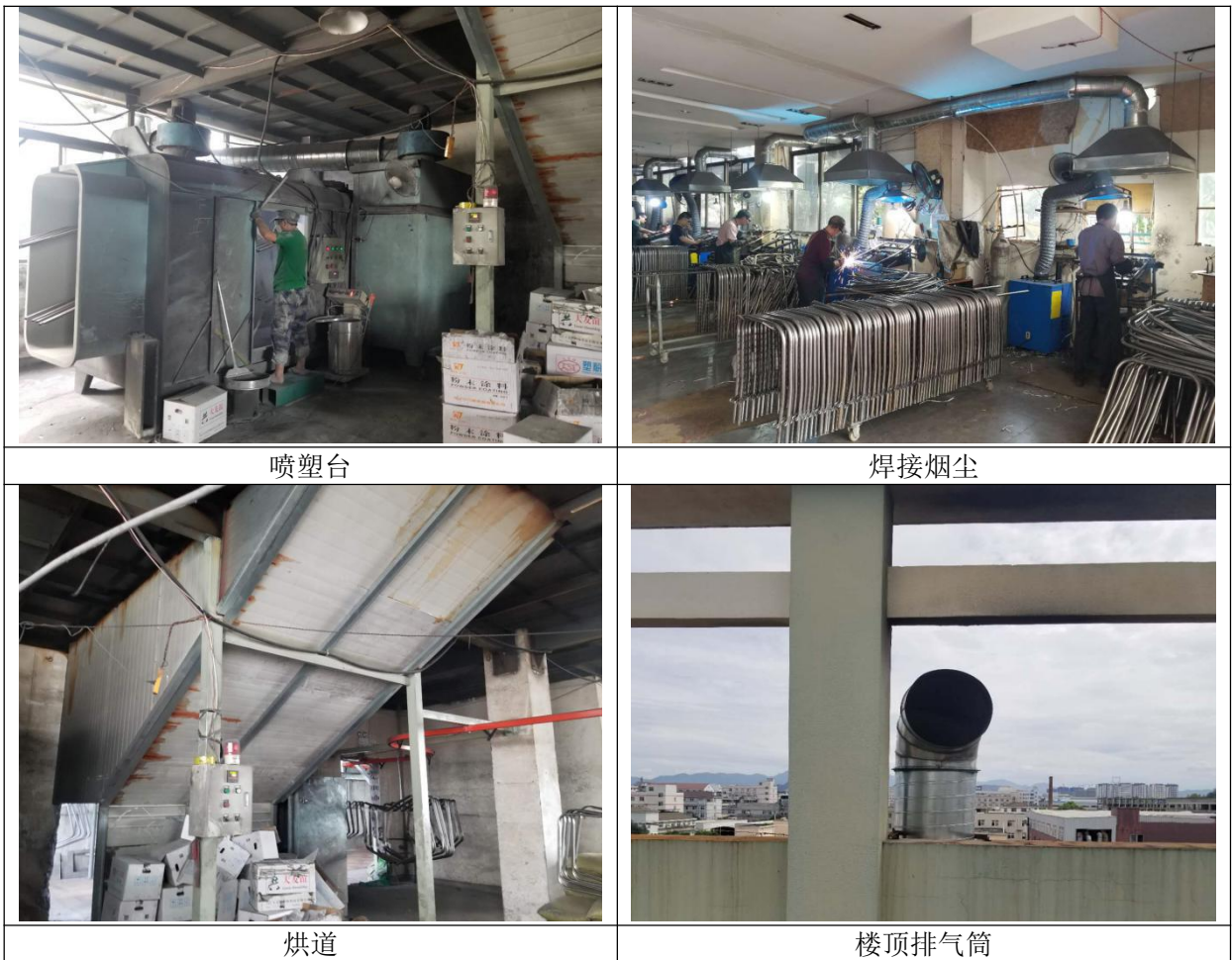
图 4-1 废气处理设施现场图
