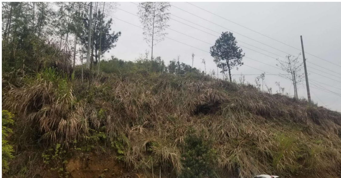
图 9-2 发电厂房道路周边植被
