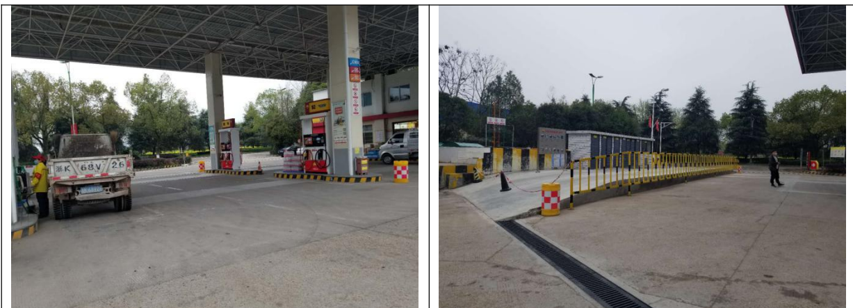
图 4-4 项目加油区、储罐区现场图
