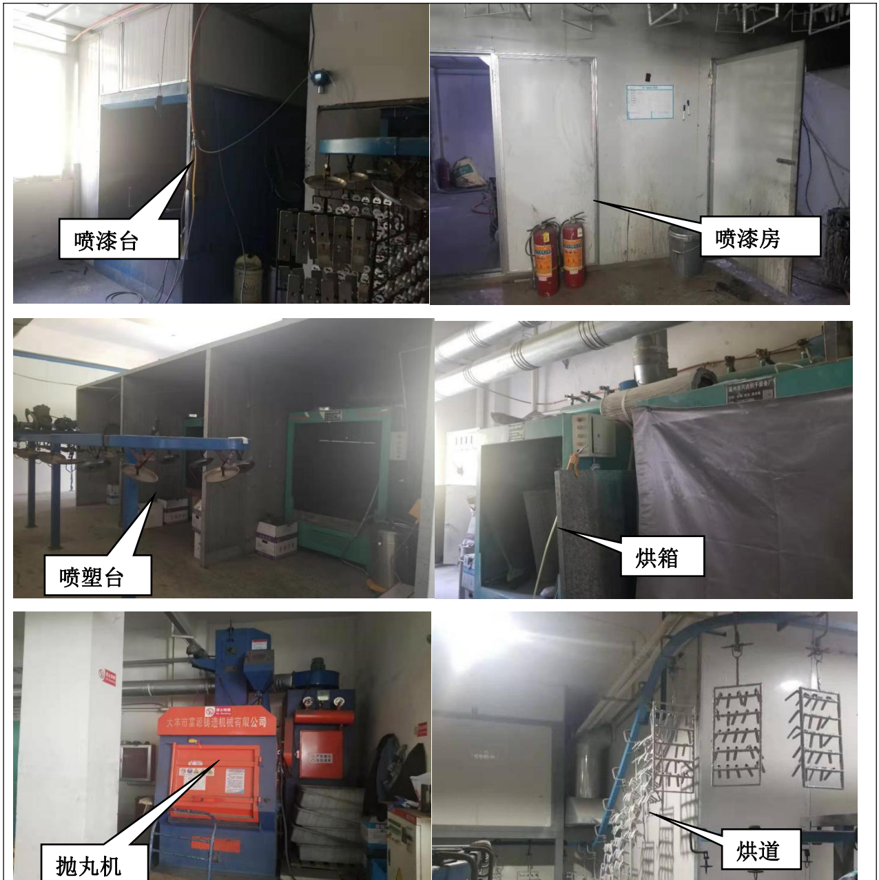
图 4-2 废气产物环节现场图
