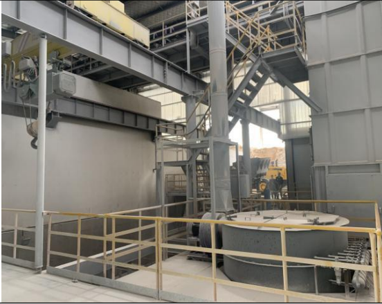
破碎车间排气筒
