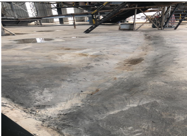
车间地面硬化、导流水槽
