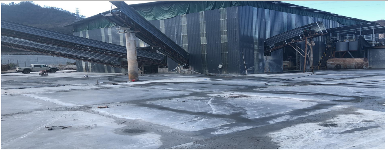
厂区整体封闭、地面硬化、输送带整体封闭
