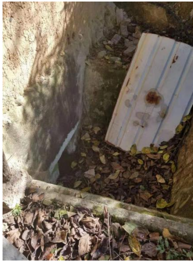
图 5-1 化粪池出口现场图
