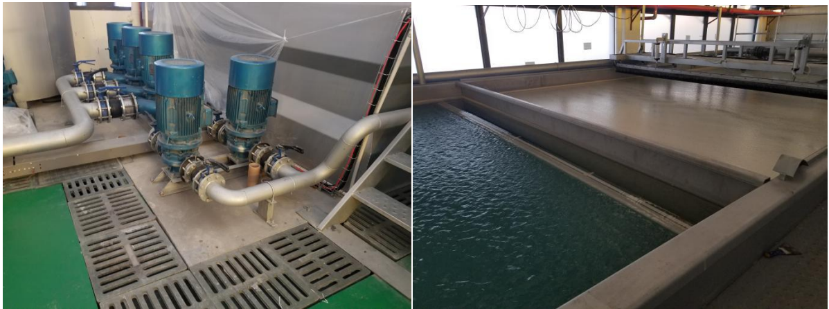
图 4-1 水刺废水处理系统
