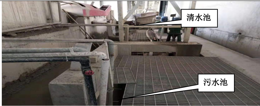
图 4-2 各水池部分现场图
