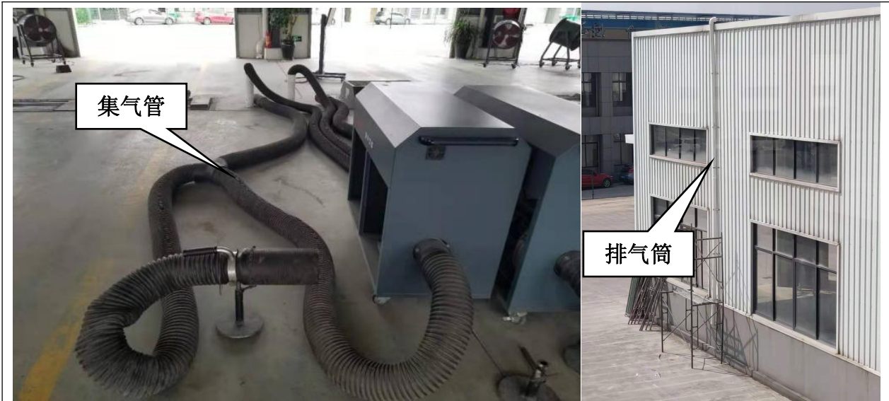
图 4-2 尾气检测现场图
