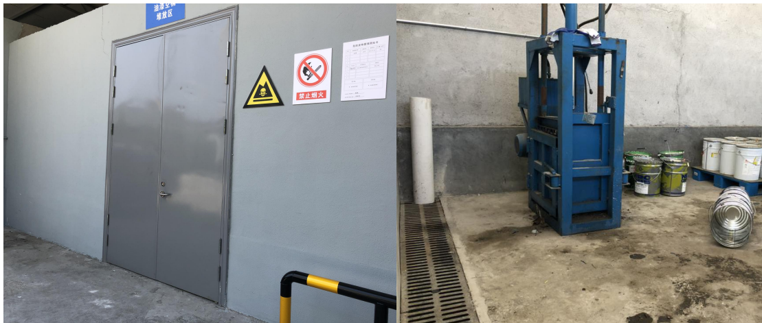
图 7.2 方正电机危废仓库现状照片
