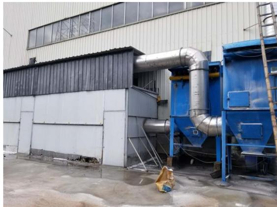
图 4-3 水喷淋、等离子净化器、布袋除尘现场图
