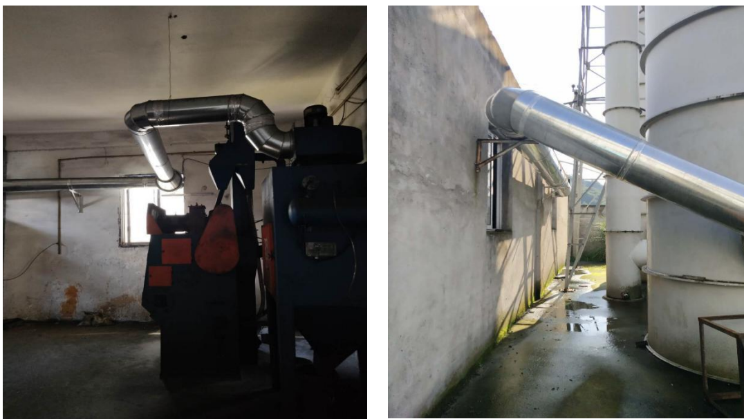
图 4-2 喷砂排气筒现场图
