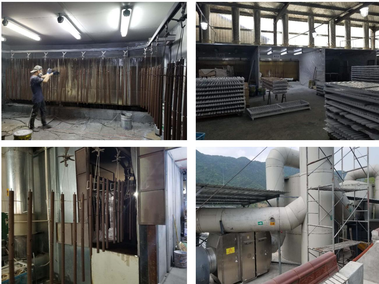
图 5-2 油漆废气处理设施现场图
