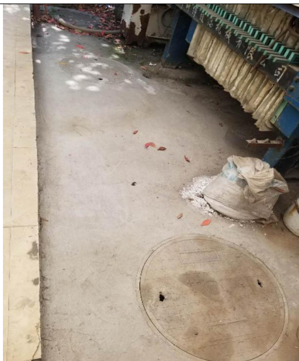
沉淀池现场图
