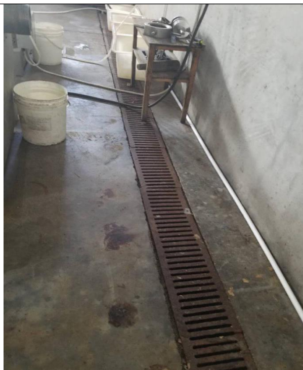
污水集水沟现场图
