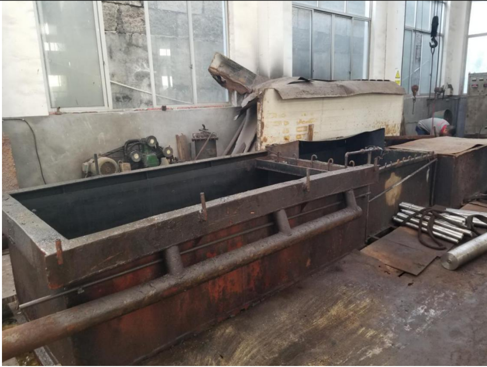
图 4-4 油淬池、水淬池现场图
