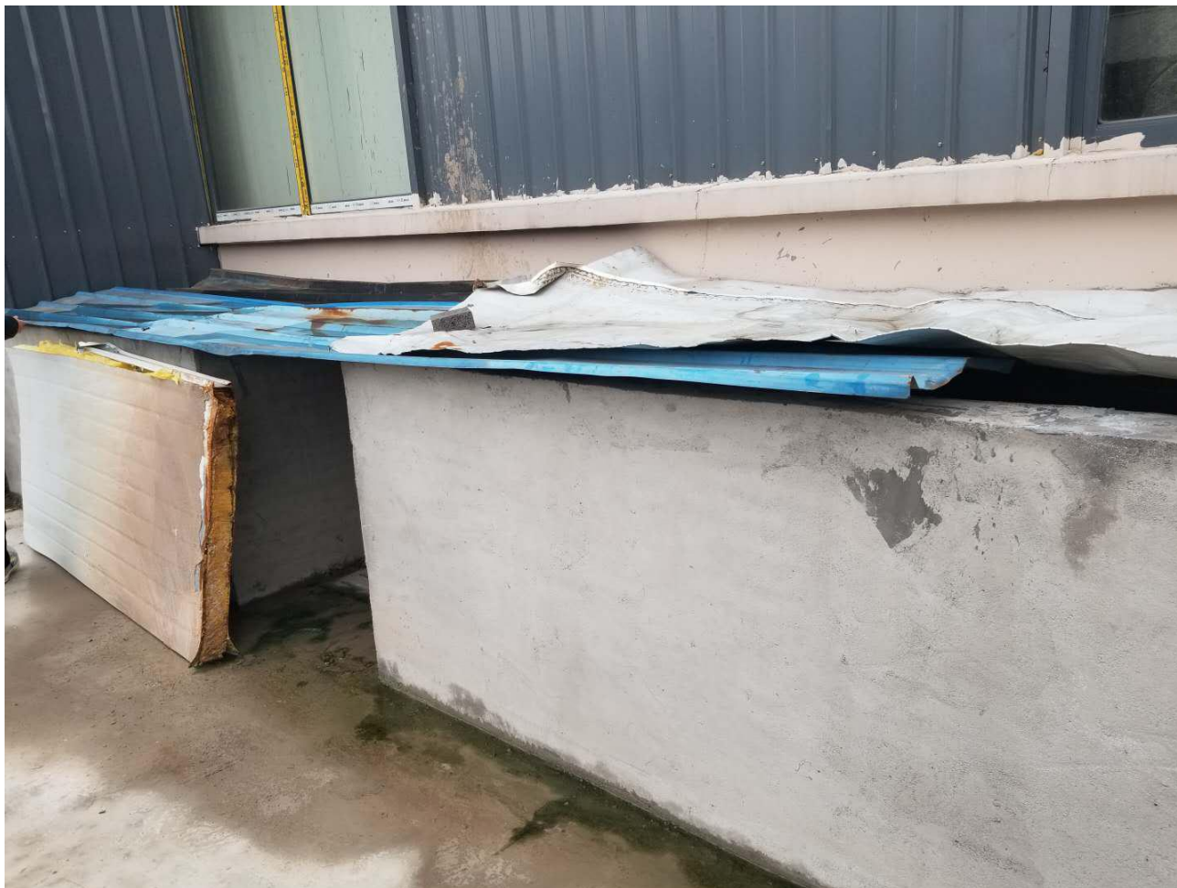
图 5-1 沉淀池现场图
