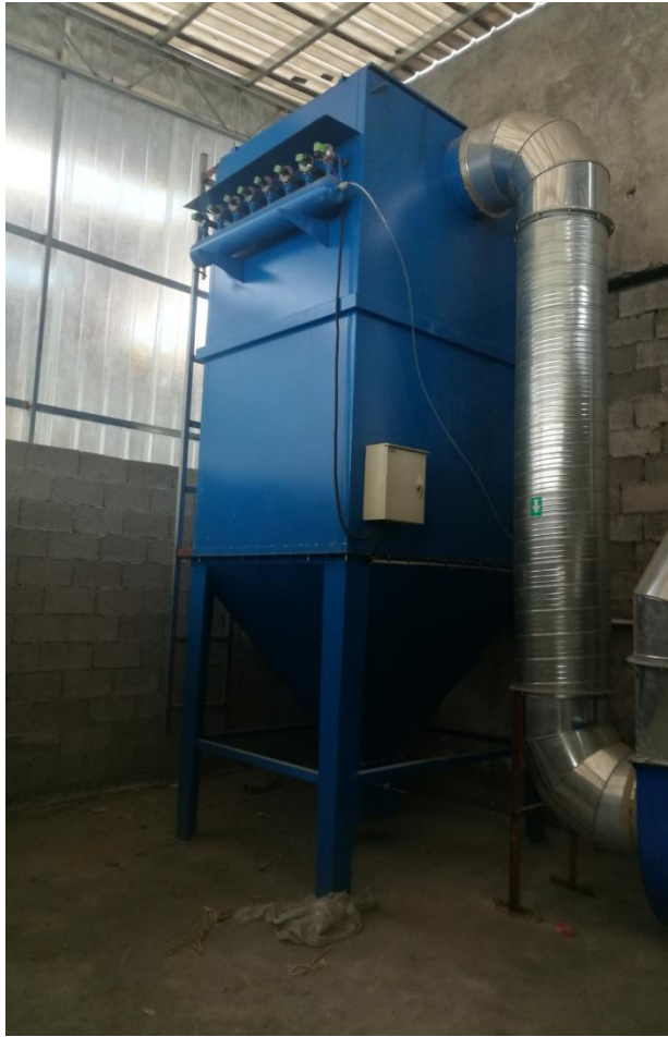
熔化、浇注废气治理设施现场照片
